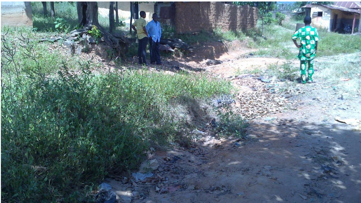
Begehen der geplante Baustelle zur Kanalisation mit dem Soziologe der NGO ED und dem Ingenieur von WBE Construction
