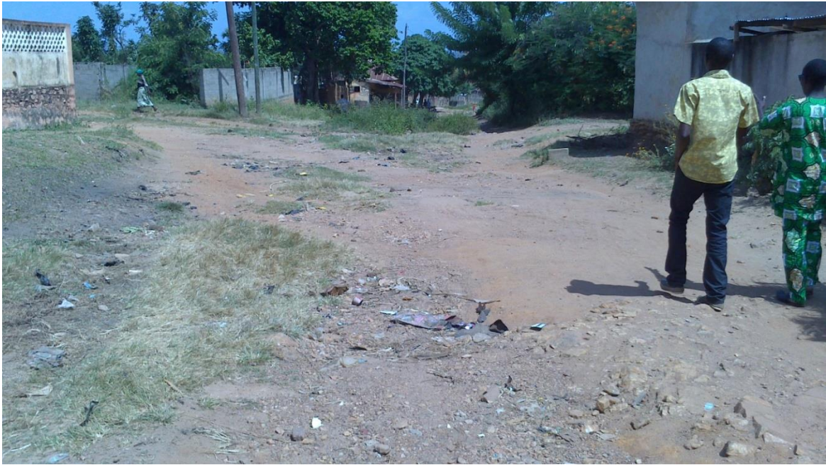
Begehen der geplante Baustelle zur Kanalisation
